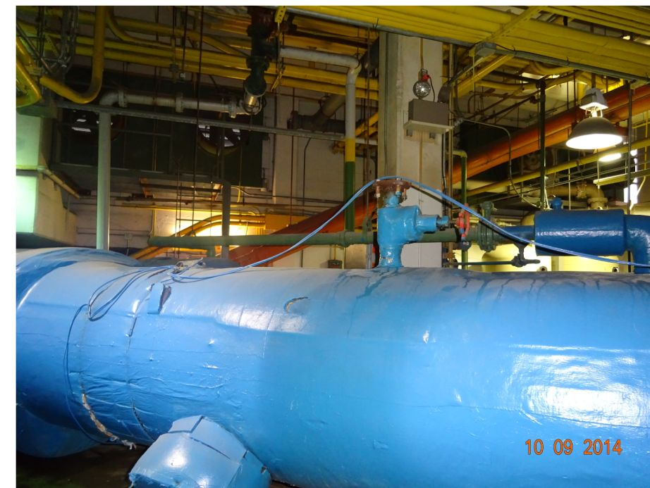
COMMERCE WEST EXISTING ULTRASONIC SENSORS SCALE: N.T.S.
